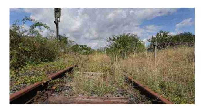
不仅如此, 坦赞铁路线路基础设施也几乎损毁得差不多了, 路基上到处都是滑坡空洞不说, 连那些小螺栓也全都锈蚀了, 此外还有近1/3的桥上枕木损毁, 2/3左右的桥栏失修, 甚至出现桥梁"裸奔"没有护栏的情况。
