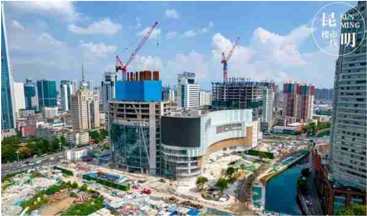
金俊广场实景（昆明楼市一线摄）
