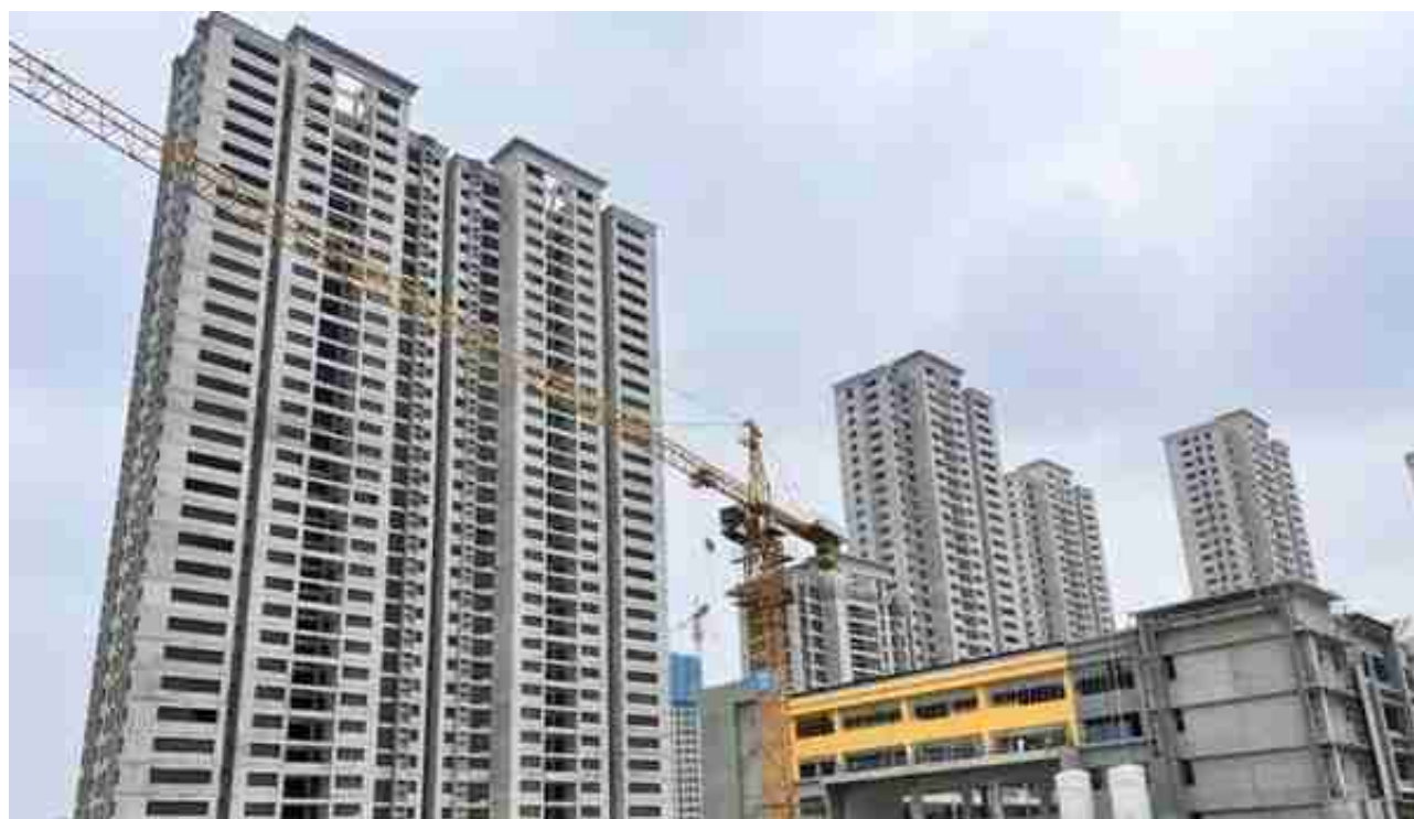
▲项目工地实景（摄于早前时间）
